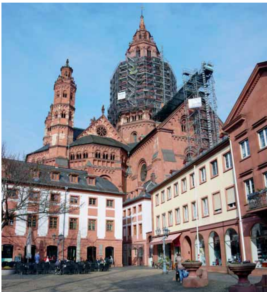
Der Mainzer Dom wird auch 2019 durch ein Gerüst „geschmückt“.
