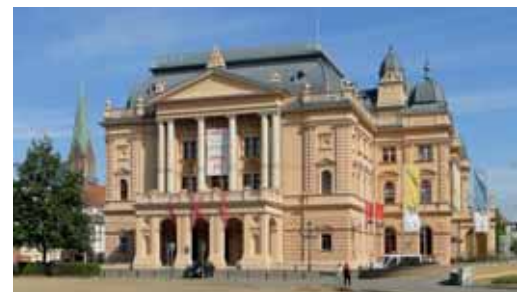
Das Mecklenburgische Staatstheater ist einer der kulturellen Prachtbauten der Landeshauptstadt.
