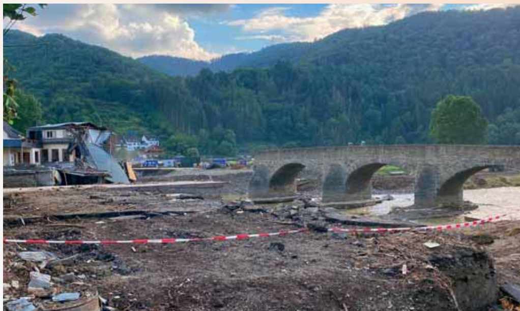
Chaos pur: So sah die historische Brücke von Rech nach der großen Flut 2021 aus. In diesem Jahr wurde sie abgerissen.
