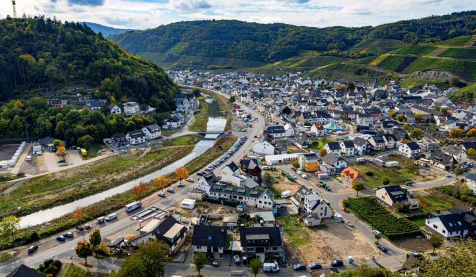
Eine Baustelle an der anderen: So sah es in Dernau 2022 nach der Flutkatastrophe im Ahrtal aus. Der Wiederaufbau wird noch jahrelang dauern.
