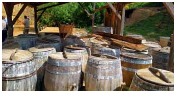
Gelöschter Kalk wird an der Burgbaustelle in Fässern aufbewahrt.
