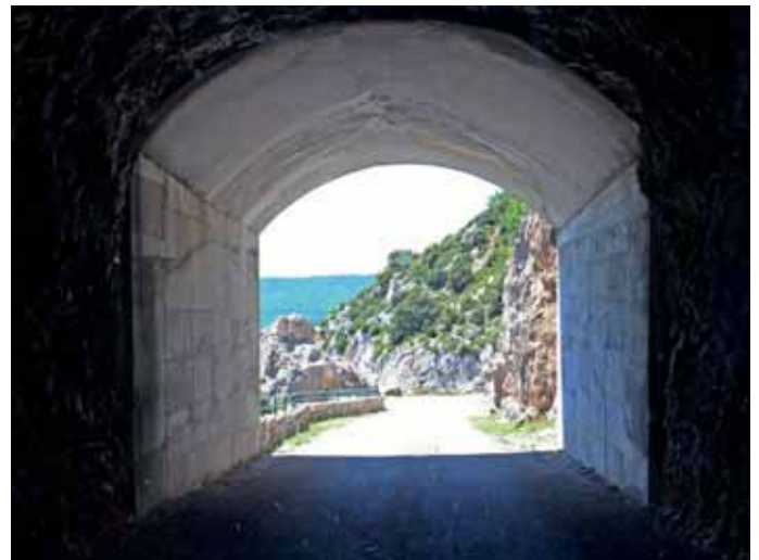
Einige Tunnels entlang der Route sind recht eng.
