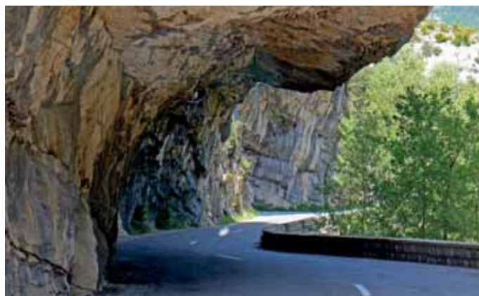
Der Felsen wurde an einigen Stellen für die Straße freigesprengt.
