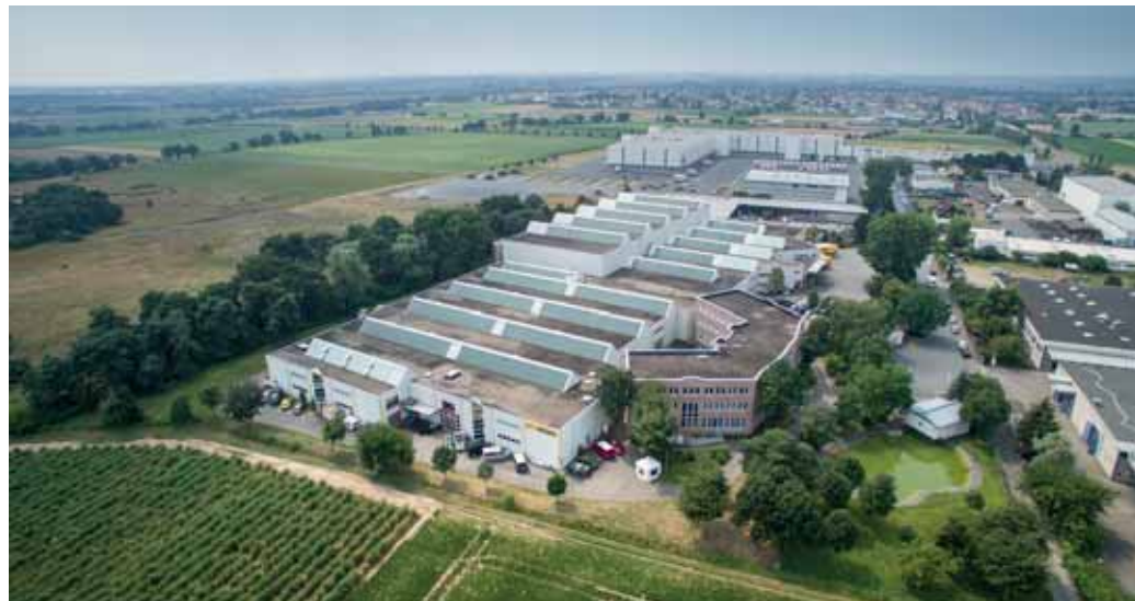
In Weiterstadt hat Reimo nun stattliche Verwaltungs- und Lagerräume.
