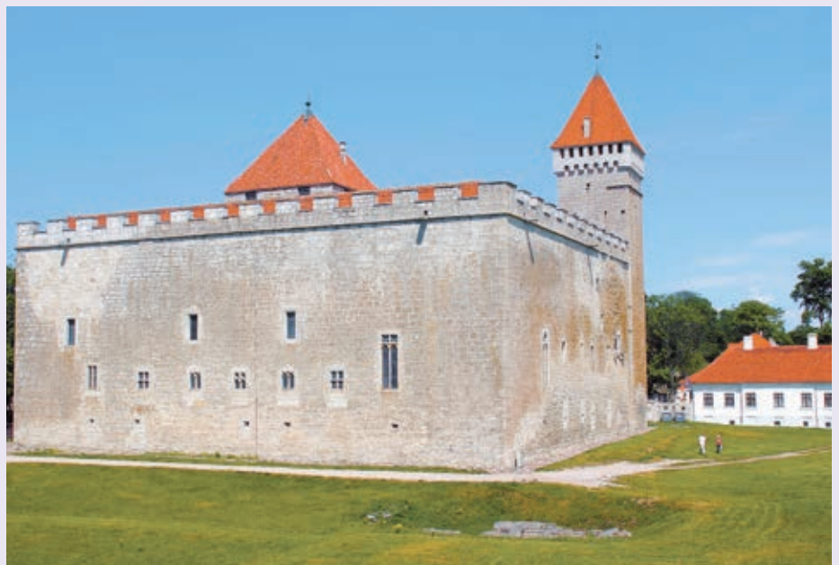
Ein trutziges Bauwerk: Die Bischofsburg in Kuresaare auf der Insel Saaremaa.
