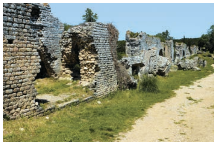
Die Ruinen des römischen Aquädukts bei Fontvielle. Es versorgte Mühlen vor 1500 Jahren.
