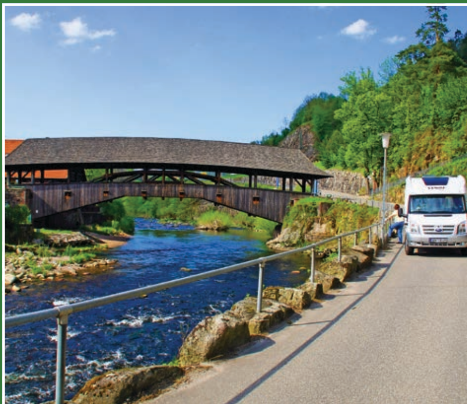
Forbach: Die größte freitragende überdachte Holzbrücke Europas ist das Wahrzeichen der Murgtal-Gemeinde. Das Bauwerk wurde 1955 erneuert.
