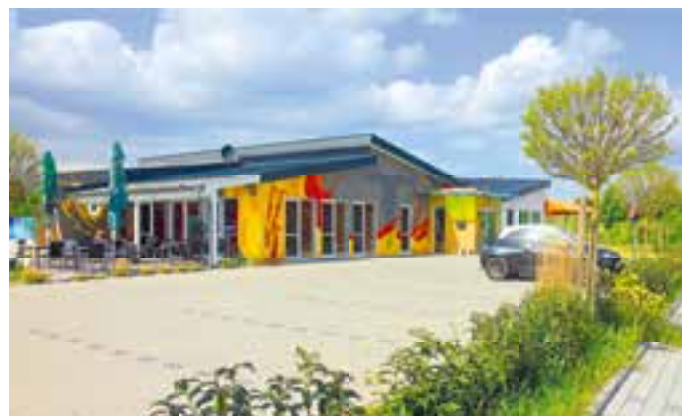
Innen und außen ein Hingucker: das Restaurant Goldschmitts.
