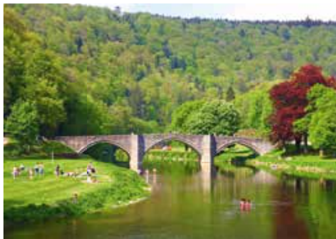
Die alte Steinbrücke überspannt die Semois.
