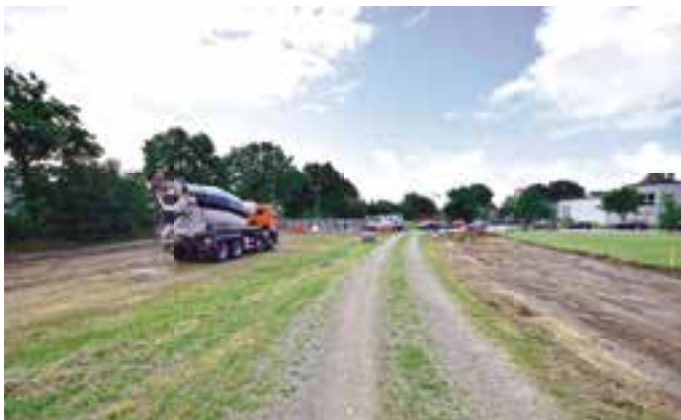
Neben dem Reimers-Betriebsgelände in Itzstedt entsteht ein neuer Stellplatz.
