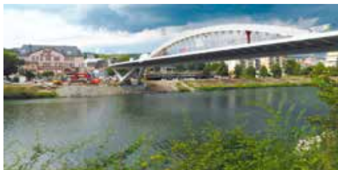
Ein futuristisch anmutende Brücke überspannt die Mosel bei Grevenmacher.
