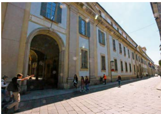
Der neoklassizistische Bau der Universität an der Strada Nuova in Pavia.
