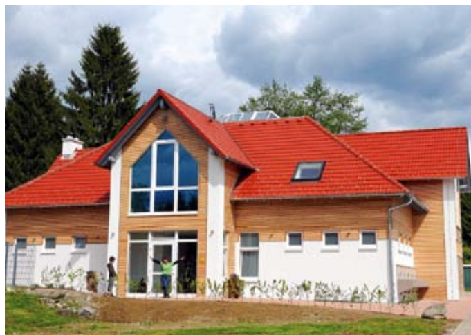
Das neue Sanitärgebäude auf dem Gitz wird höchsten Ansprüchen gerecht.
