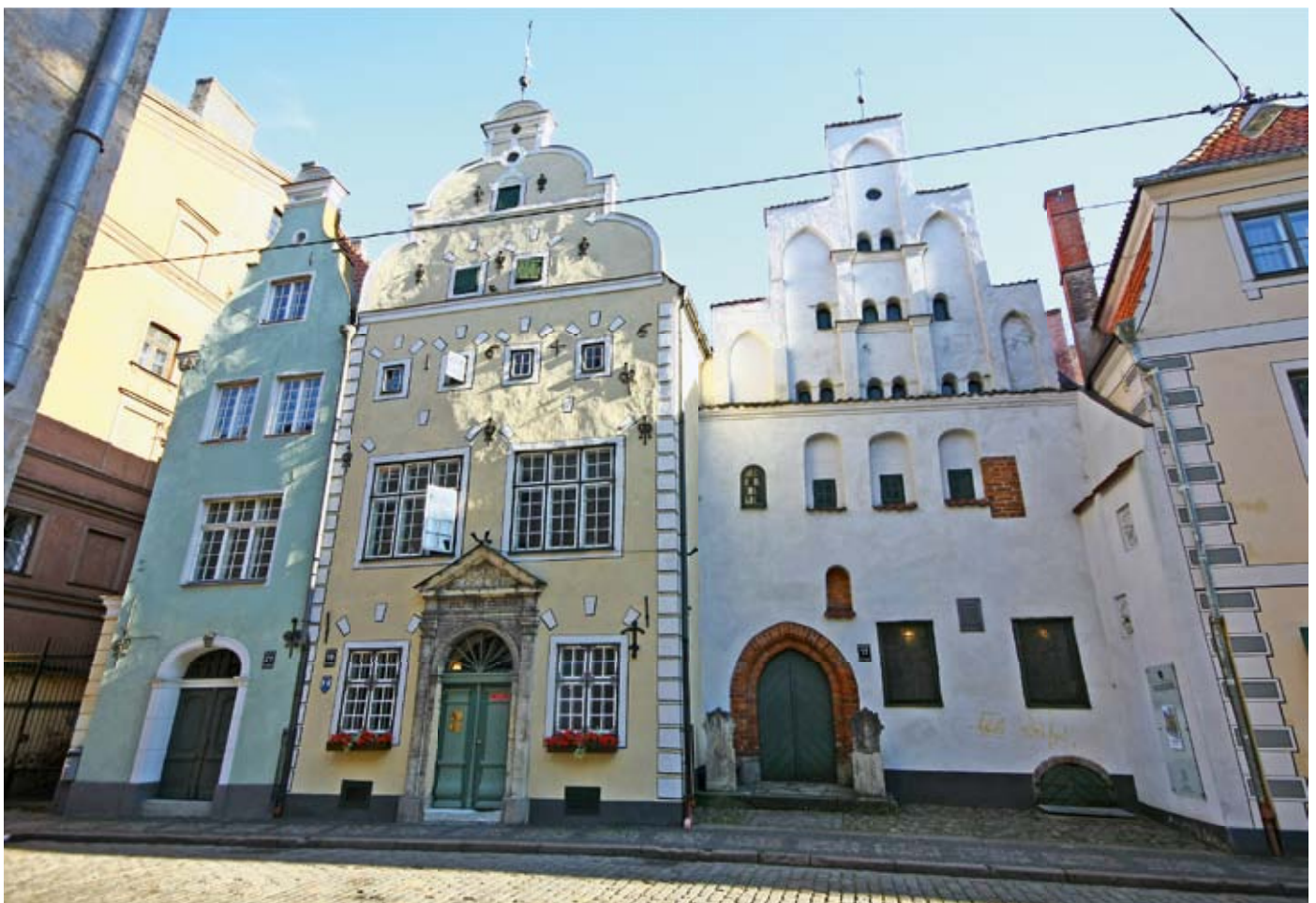
Die Drei Brüder (lettisch Trīs brāļi) sind ein Gebäudeensemble in der Altstadt von Riga. Das Haus 17 ist das älteste profane Steingebäude im Stadtgebiet.
