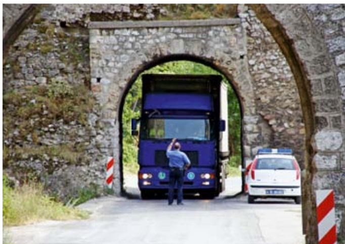
Maßarbeit: Die Durchfahrt bei Burg Golubac.
