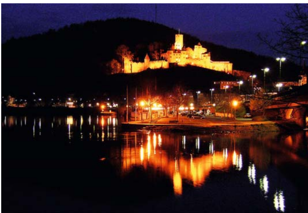
Die Burg von Wertheim dominiert über der Stadt.
