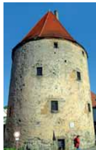
Bis zu drei Meter dick sind die Mauern des Pulverturms, der einst als Kriminalgefängnis diente.
