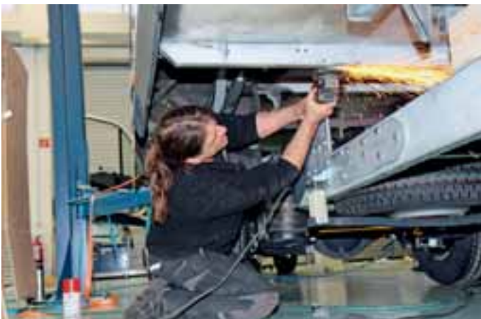
Der Hilfsrahmen des Phoenix-Aufbaus wurde an das Chassis des Jahrgangs 2011 angepasst.
