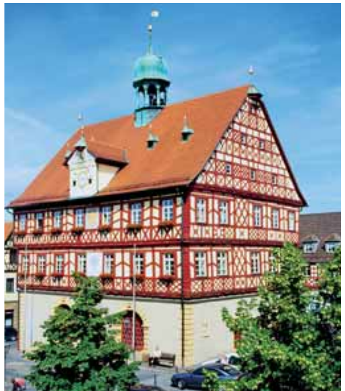
Ein Vorzeige-Fachwerkhaus: das Rathaus in Bad Staffelstein.
